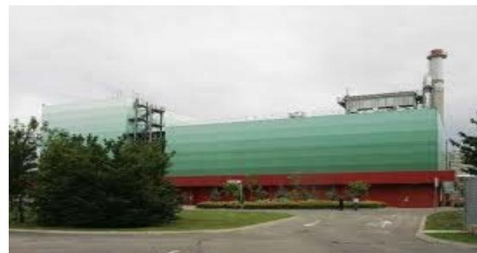
Nel 2012, mediante una modifica alla turbina dell'impianto, è stato fortemente incrementato il recupero di calore (prima disperso) da parte del termovalorizzatore di via Goltara. Entro il 2018 è prevista la posa di oltre 80 km di tubazioni, che consentirà l'allacciamento di circa 10 milioni di metri cubi di edifici.
